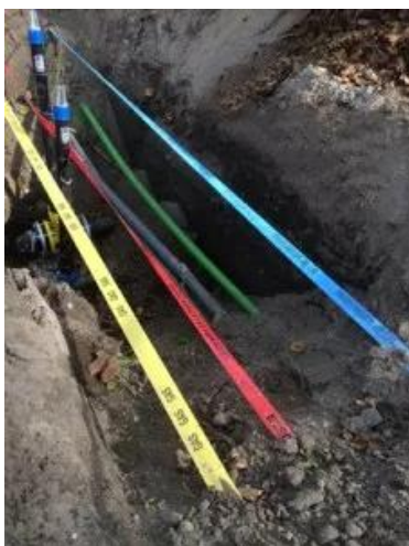
Figuur 5: voorbeeld grondkabel (lint)
