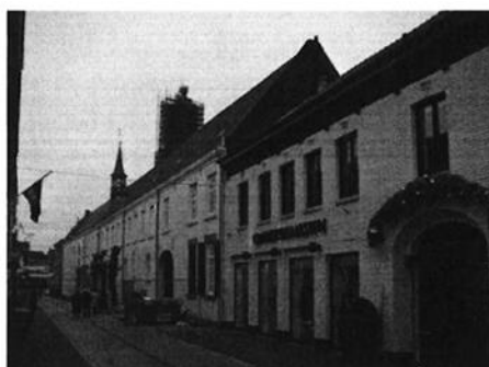
Noordzijde Maasstraat ter hoogte van klooster
