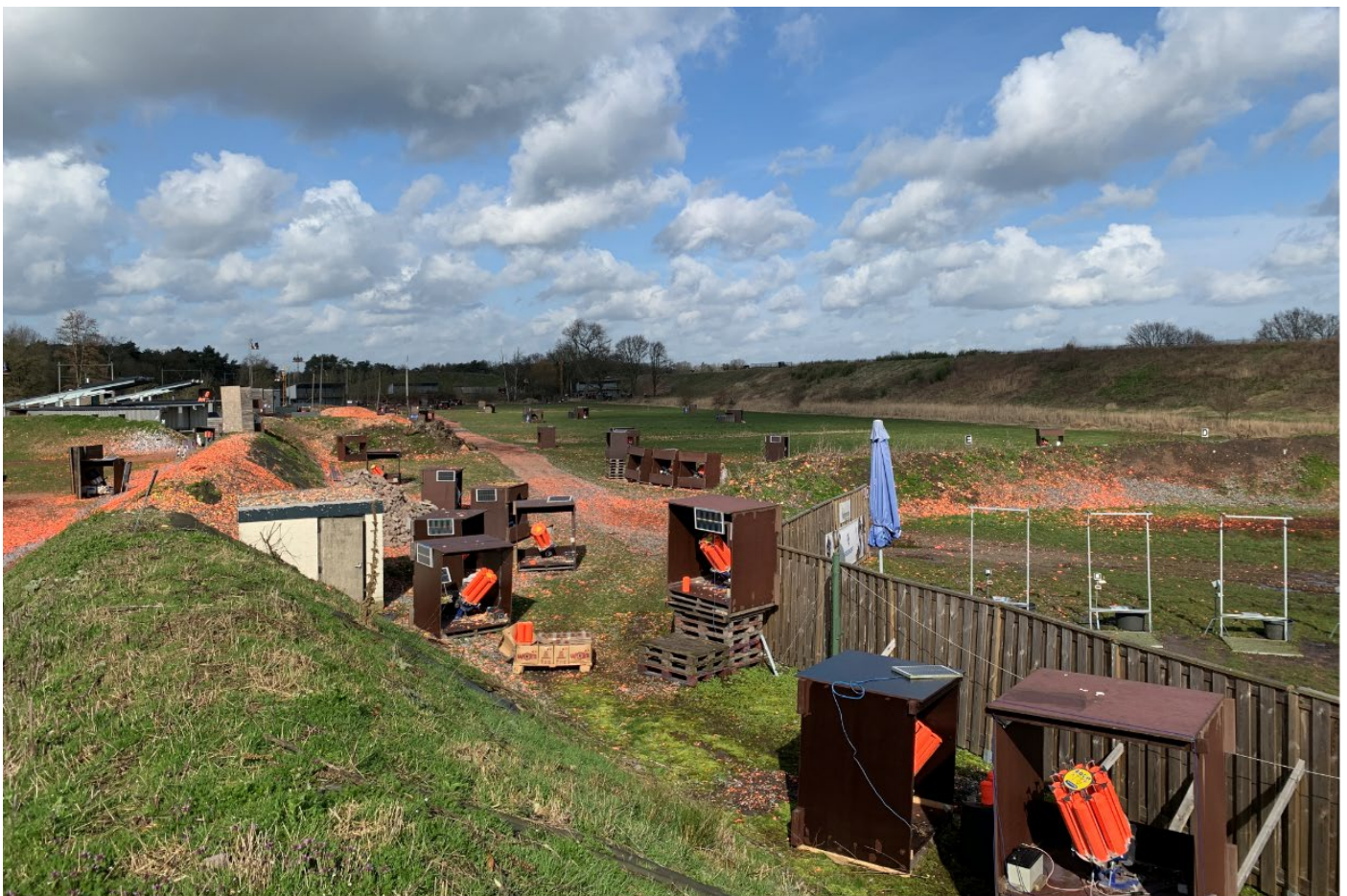
Figuur 2. Overzicht van de schietbaan. Rechtsboven is de brede geluidswal te zien. Haaks hierop zullen nieuwe geluidswallen worden aangelegd.
