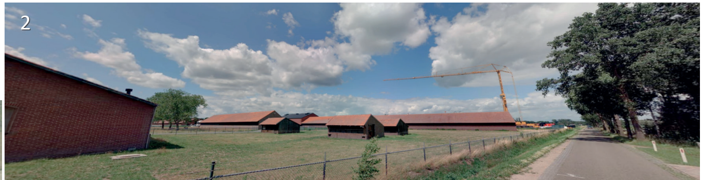
Zicht richting noordwesten op velden zonnepanelen vanuit Heltenbosdijk
