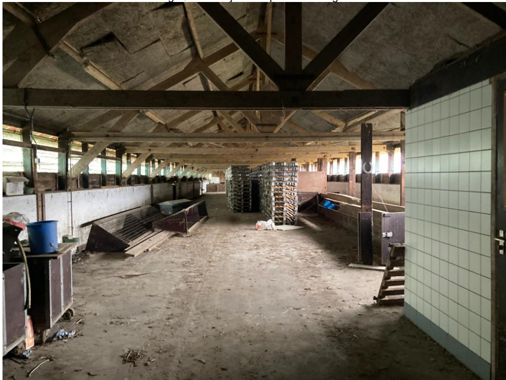
• Afbeelding 23: binnenzijde te slopen bebouwing fase 2
