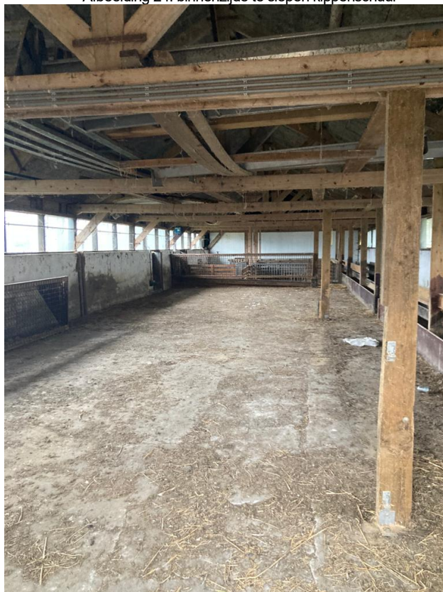
• Afbeelding 24: binnenzijde te slopen kippenschuur
