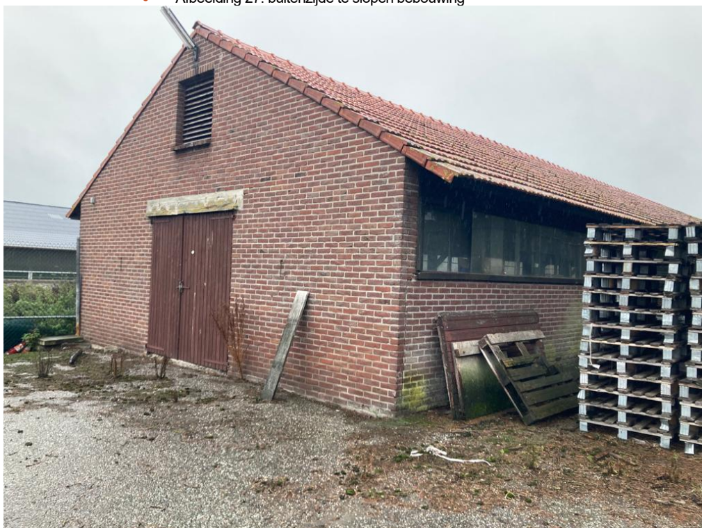
• Afbeelding 27: buitenzijde te slopen bebouwing
