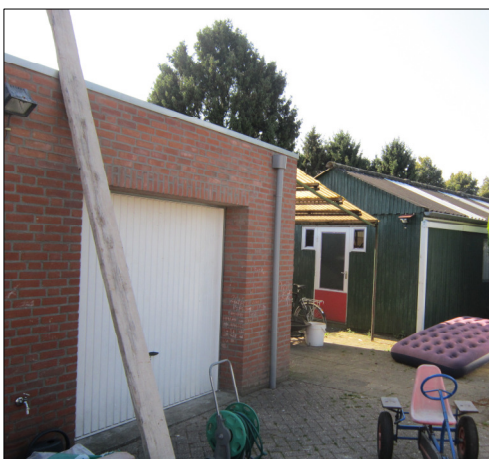
dubbele garage en houten gebouw
