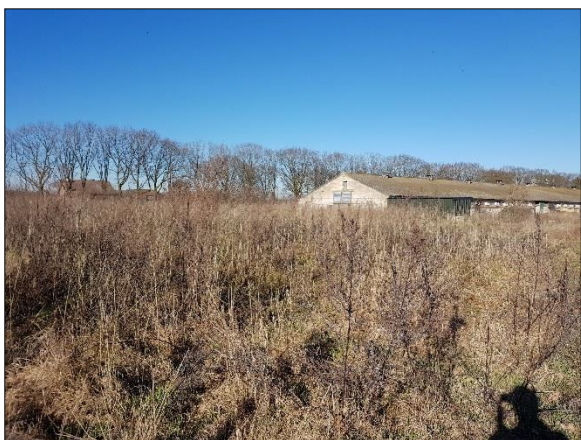
Figuur 7. Locatie zonnepanelen westzijde
