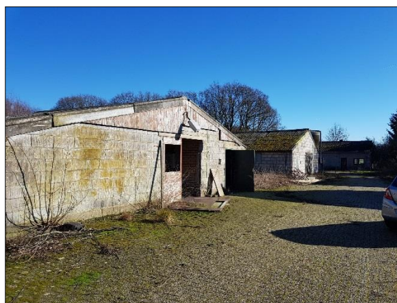
Figuur 4. Te slopen stallen in oostelijk deel
