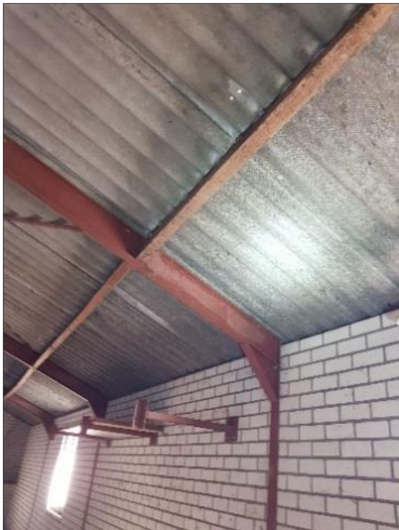
Figuur 5. Binnenzijde te slopen garage
