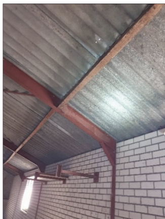
Figuur 6. Binnenzijde te slopen garage
