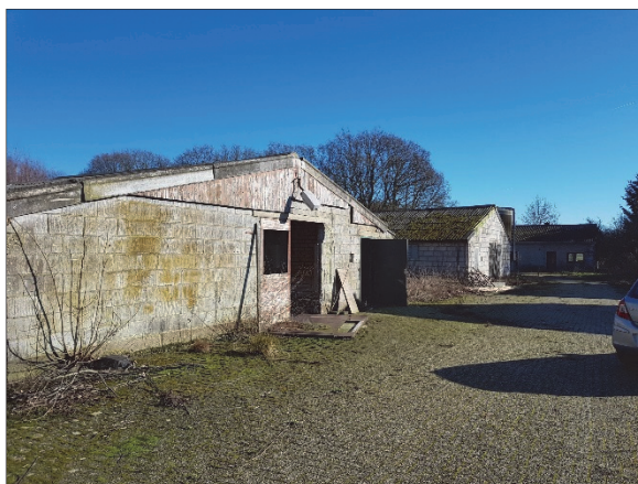
Figuur 5. Te slopen stallen in oostelijk deel
