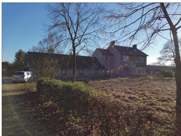
Figuur 4. Woonhuis vanaf straatzijde
