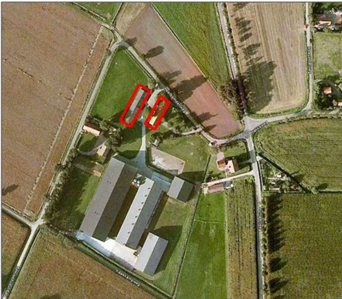
Figuur 1: Rood omlijnd de te slopen stal (links) en woonhuis (rechts).
