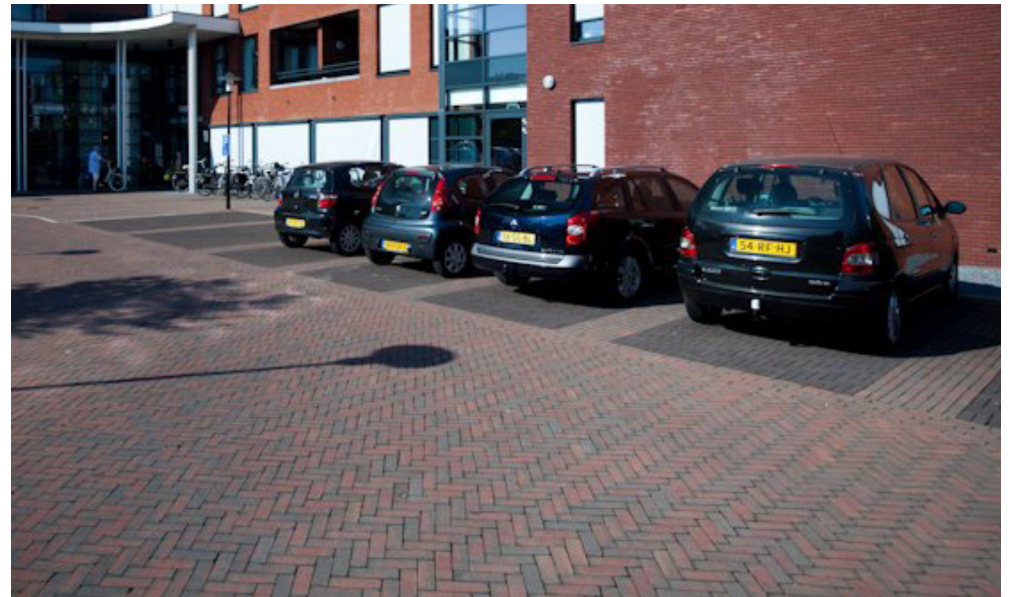
Strak bestrate parkeerplaats (haaksparkeren) met ondergrondse koffers voor wateropvang
