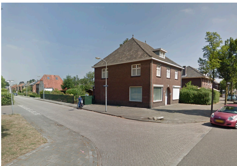
Figuur 3: Bestaande bebouwing Boshoverweg 51
