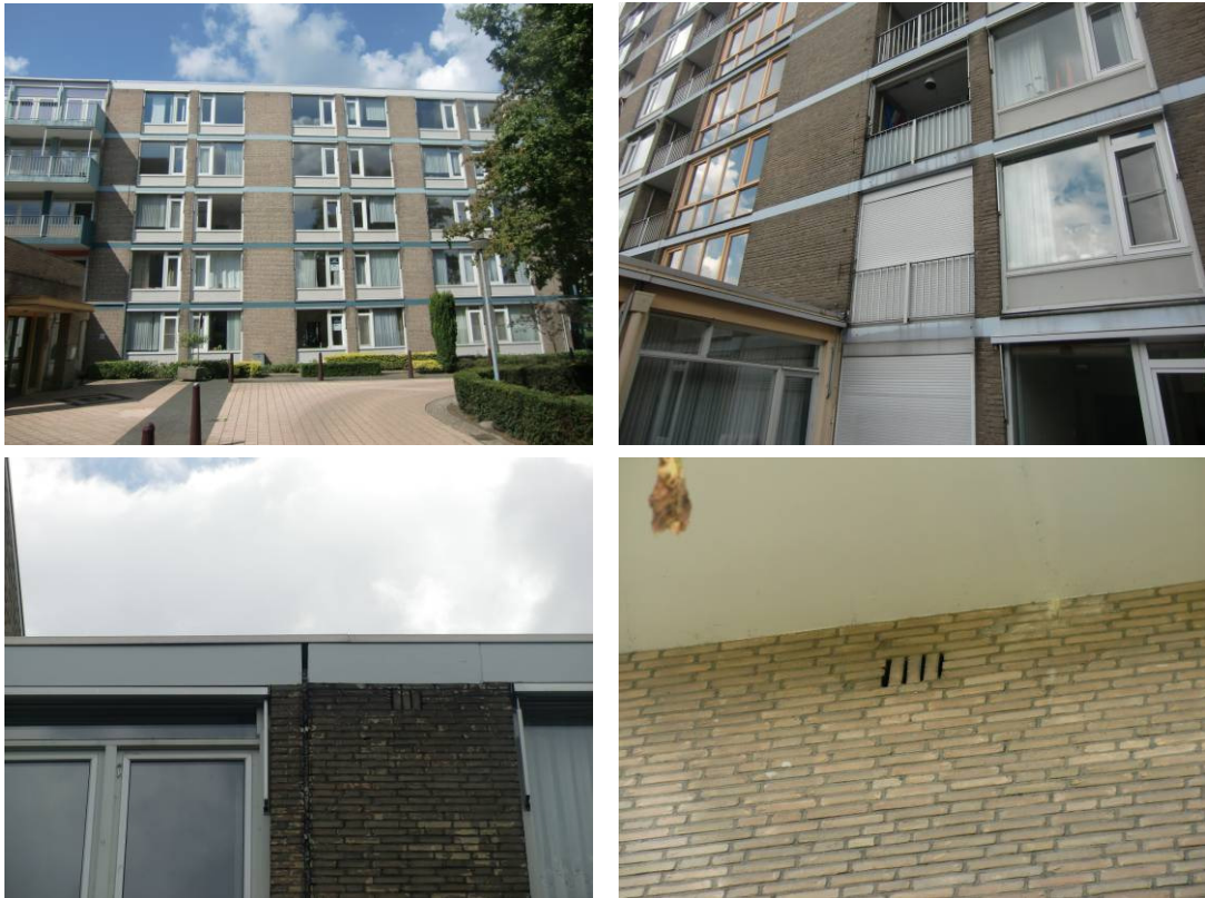
Figuur 7. Impressies gebouwen. Lb: impressie gebouw, Lo: gat in boeiboord, Rb: rolluik, Ro: stootvoegen.
