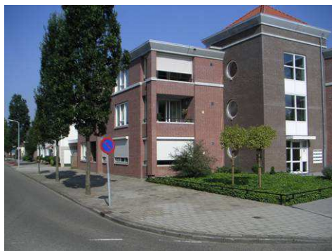
Nieuwbouw hoek Victor de Stuersstraat
