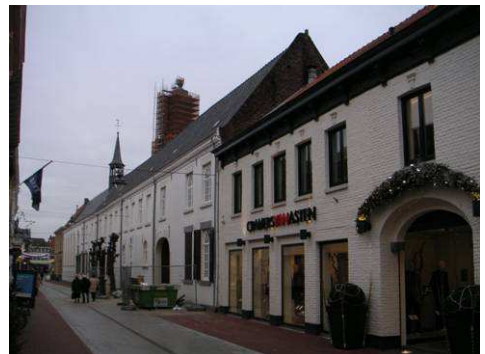
Noordzijde Maasstraat ter hoogte van klooster
