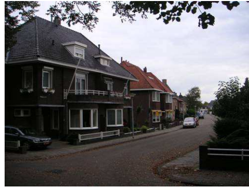
Observantenstraat vanaf het kanaal
