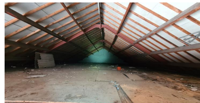
Figuur 6: Zolderruimte van de opstal
