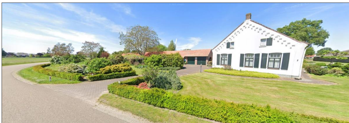
Zicht op bebouwing Vlootkant 1 en 3 vanaf kruising Vlootkant – Soutsweg (Bron: Google Streetview, juni 2021)
