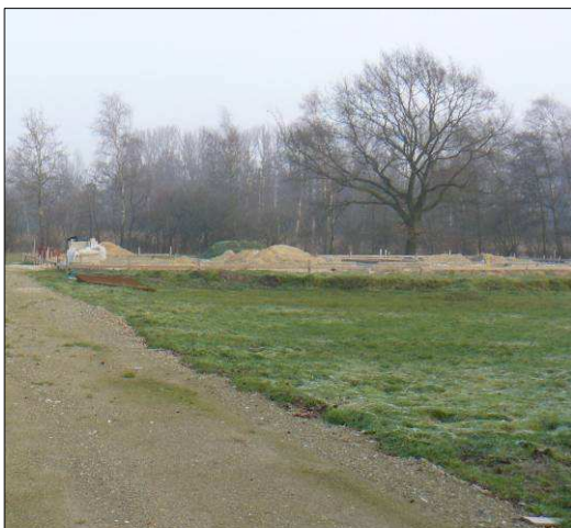
bouw nieuwe woning nabij plangebied
