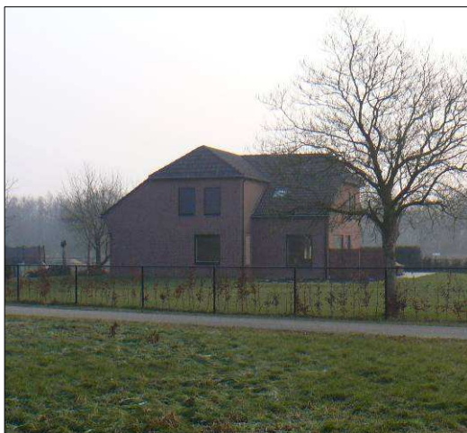
bestaande woonhuis Vensteeg 2
