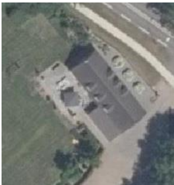
Luchtfoto waarop duidelijk zichtbaar de bestrating achter de bestaande woning.
