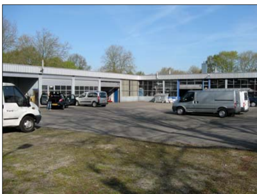
Afbeelding 3. Zicht op het garagebedrijf, gezien vanuit het zuidoosten.
