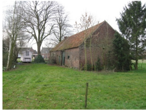
Foto 2. De oude schuur, deels omgeven door door opgaande beplanting, vanaf de Rakerstraat in zuidwestelijke richting gezien.
