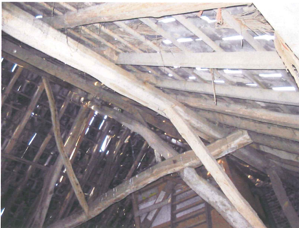
Figuur 6 Dak zolder voormalige varkensstal
