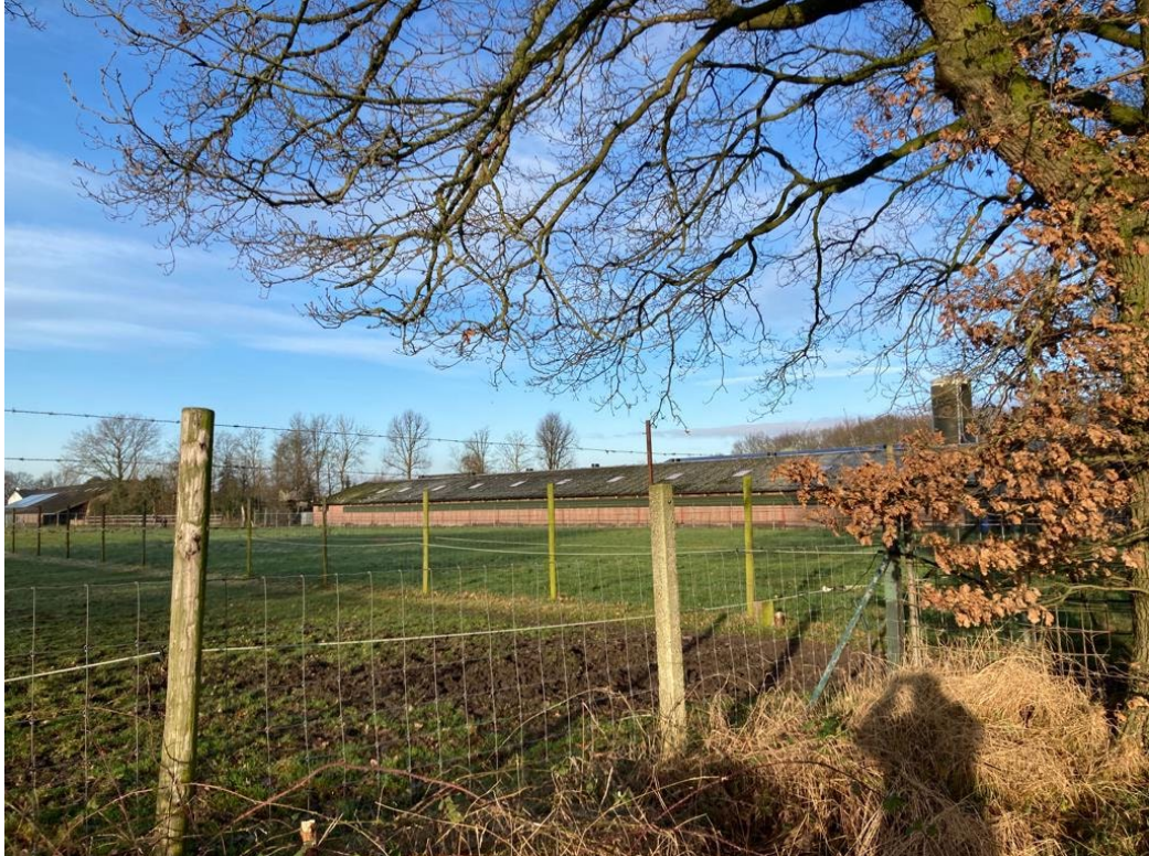
• Afbeelding 3: uitzicht perceel naar de bestaande stallen
