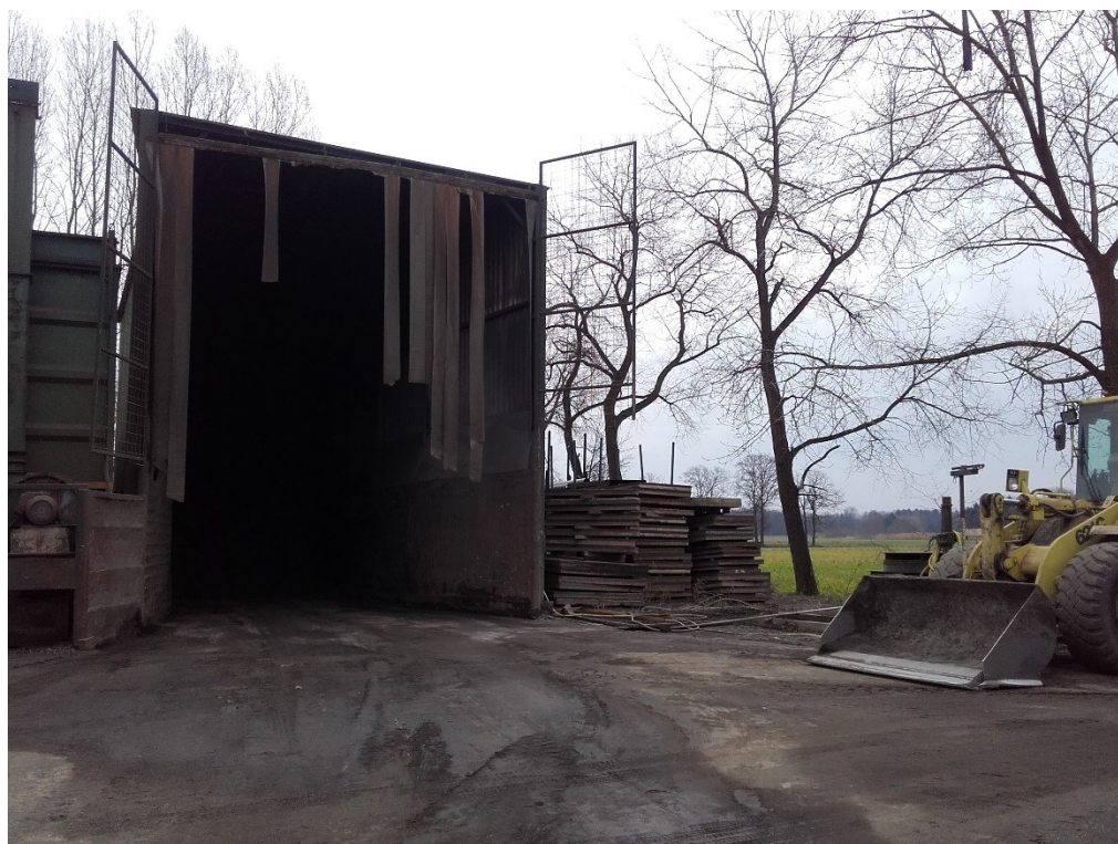
Foto: zuidoosthoek terrein, opslag straalgrit, kijkrichting zuidoost
