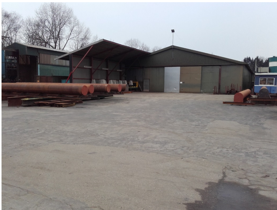
Foto: oostzijde terrein met zicht op loods centraal op terrein, kijkrichting west
