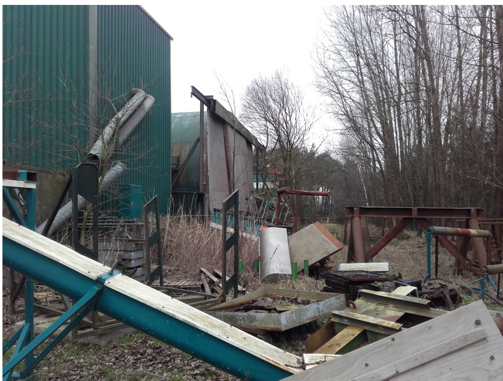
Foto: zuidoosthoek terrein, achterzijde loodsen, kijkrichting noord (situatie februari 2016)
