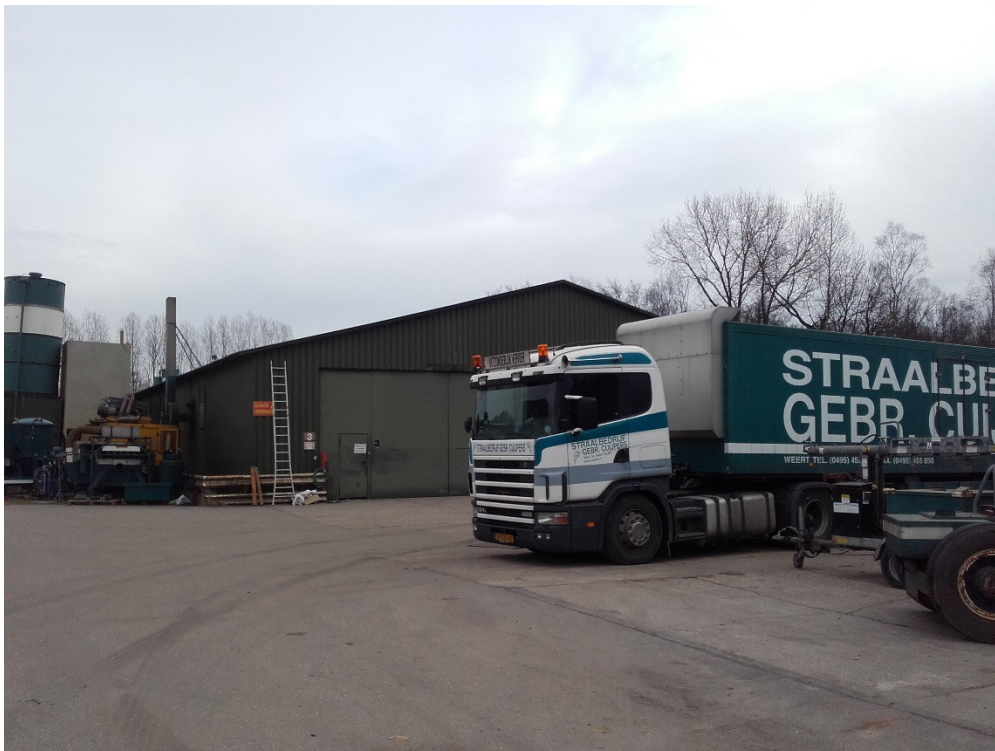
Foto: loods centraal op terrein, kijkrichting zuidoost
