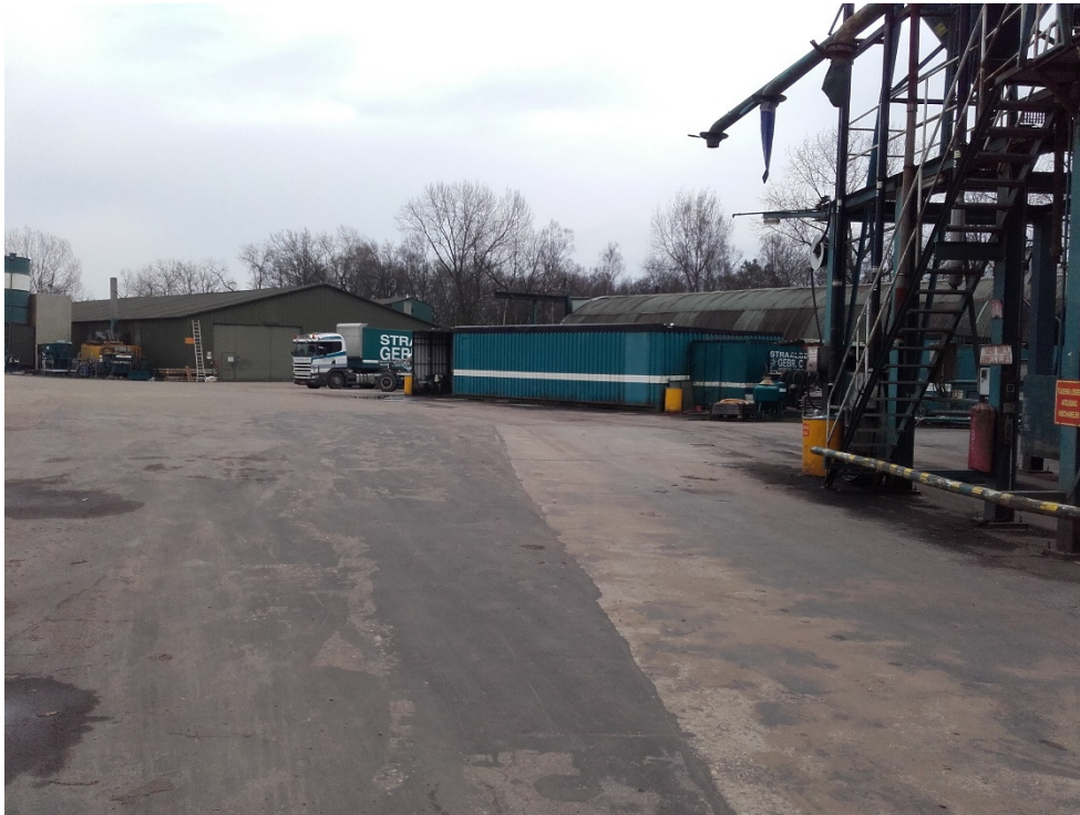
Foto: ingang terrein, rechts afvulinstallatie straalgrit, kijkrichting zuidoost
