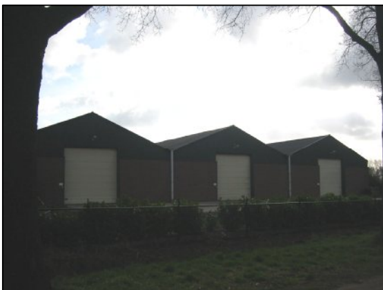
Figuur 9.6: geschakelde loodsen, welke zullen worden behouden
