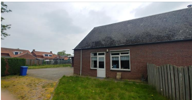
Figuur 4: Zuidgevel voormalige bakkerij
