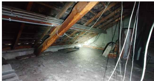
Figuur 5: Zolder van aanbouw tussen woonhuis en voormalige bakkerij
