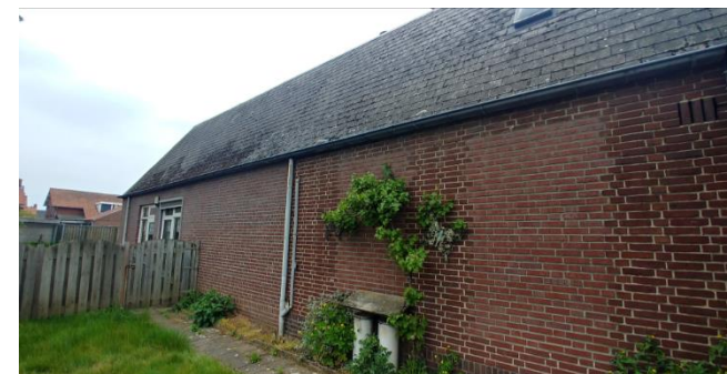
Figuur 5: Zuidgevel voormalige bakkerij
