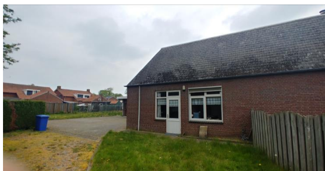
Figuur 8: Zuidgevel voormalige bakkerij
