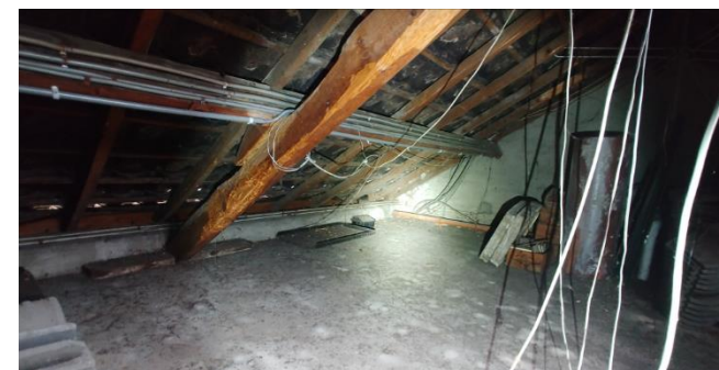
Figuur 6: Zolder van aanbouw tussen woonhuis en voormalige bakkerij
