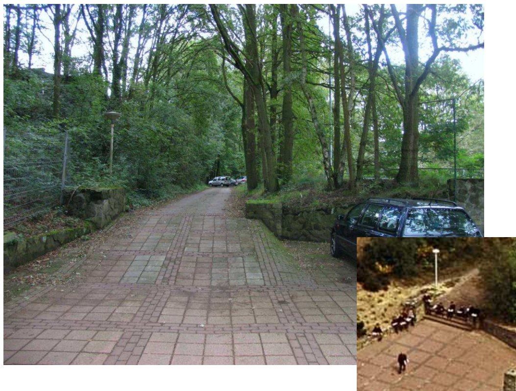
Pad naar middengebied met later toegevoegde hellingbaan t.p.v. (verwijderde?) trap; keermuurtjes en trap waren essentieel in het plan van architect Pierre Weegels als ruimtestructurerende elementen ('afspraken in de ruimte'), inzet: oorspronkelijke trap
