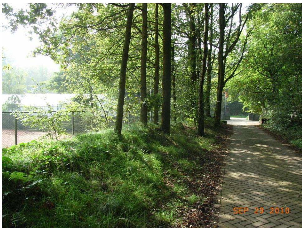
Wal langs zwembad, gezien richting entree, met veel doorgeschoten bomen en ontbrekende afschermende onderbegroeiing
