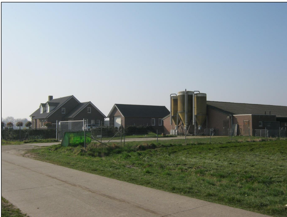
Afbeelding 3.2.3 Zicht op de locatie Dijkerakkerstraat 2 met op de voorgrond de bestaande stal en op de achtergrond de bedrijfswoning
