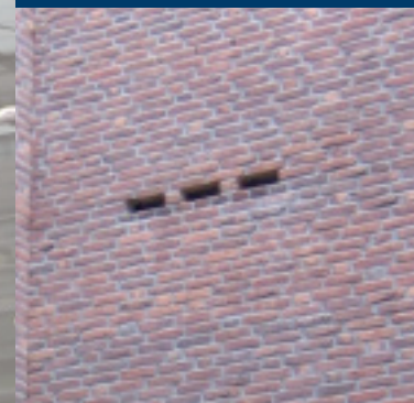
Maatwerk inbouwkasten bij het gebouw van het Wereld Natuurfonds in Zeist
