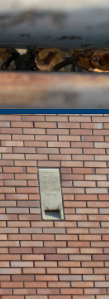
Boven: dwergvleermuizen in een kraamkast
