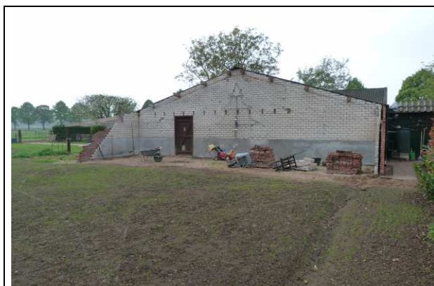
Foto 3. Deels afgebroken loods noordzijde plangebied
