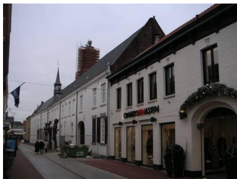
Noordzijde Maasstraat ter hoogte van klooster
