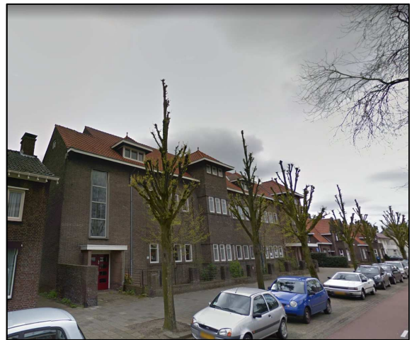
Figuur 4. Emmasingel 37 vanuit noordwesten (Google Street-view)
