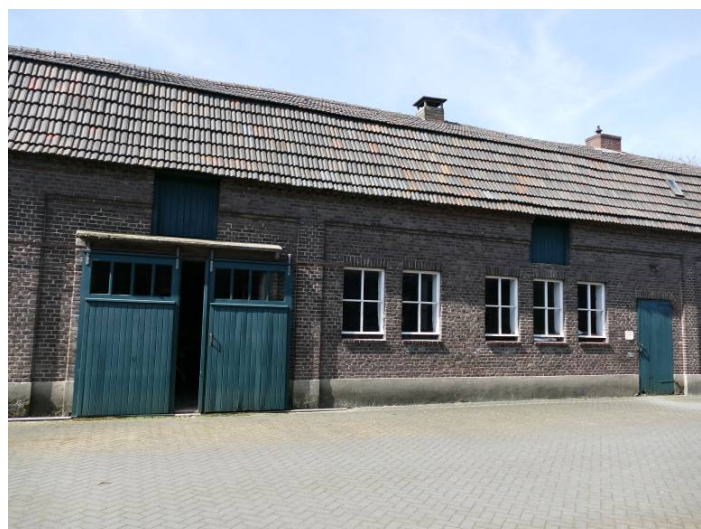
Figuur 14 Betonnen stalramen met ventilatiegleuf en schuifdeur ter plaatse van voormalige deeldeuren
