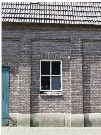
Figuur 13 In de plint en het muurwerk boven het raam is nog zichtbaar dat hier voorheen een loopdeur was
