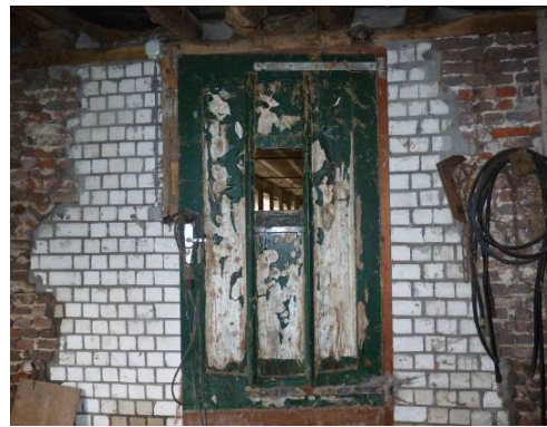
Figuur 44 De binnendeur naar voormalige schapenstal is een hergebruikte voordeur
