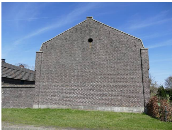
Figuur 39 Bij de eindgevel van de schuur eindigt de dakrand op het midden van de hoekliseen. Bovenin een rond oeil-de-boeuf.
