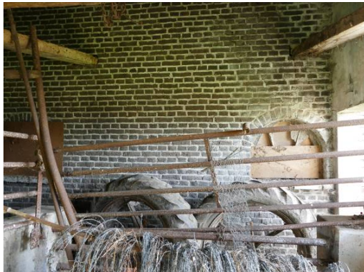
Figuur 27 Oorspronkelijke achtergevel (westzijde) met raam. Thans binnenmuur
