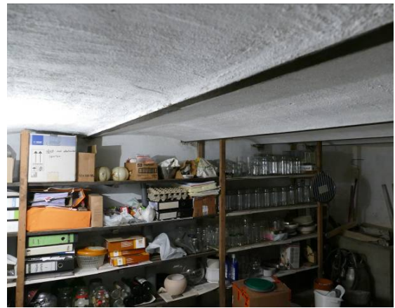
Figuur 24 Kelder met plafond van ijzeren balken en troggewelven
