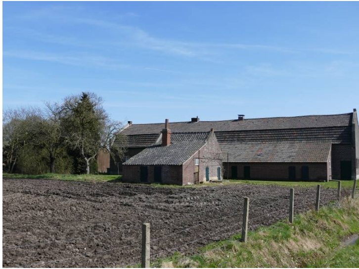
Figuur 7 Boerderij en bakhuis met hun aanbouw. Links achter het geboomte staat een wagenloods en varkensschuur. Op het dak van de boerderij boven de stal een luchtkoker
