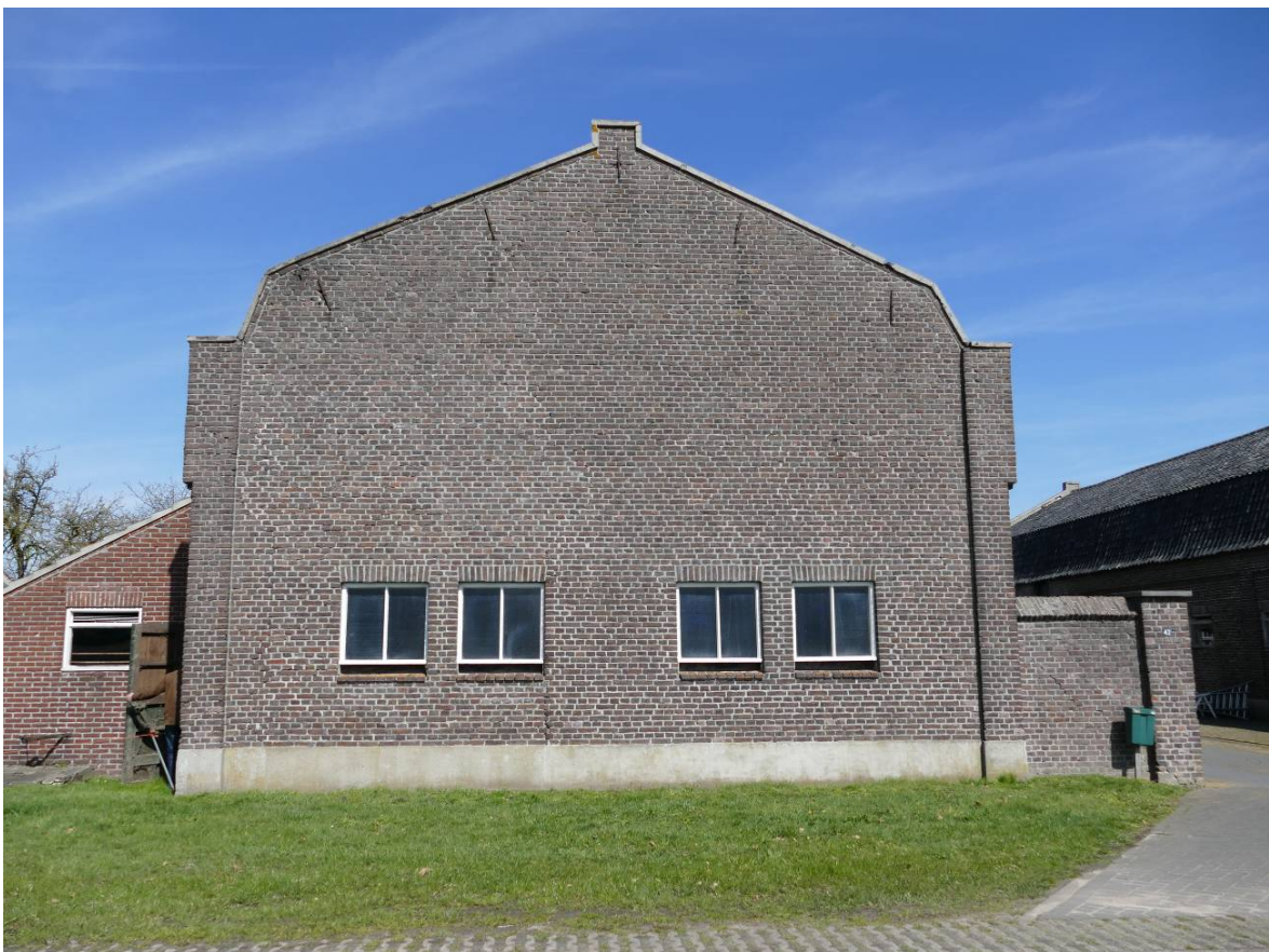
Figuur 19 In de eindgevel geeft een lichte tekening in het muurwerk en de plint de plaats aan van voormalige deeldeuren
