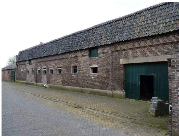
Figuur 36 Ook de voorgevel van de schuur is opgebouwd uit lisenen met spaarvelden
