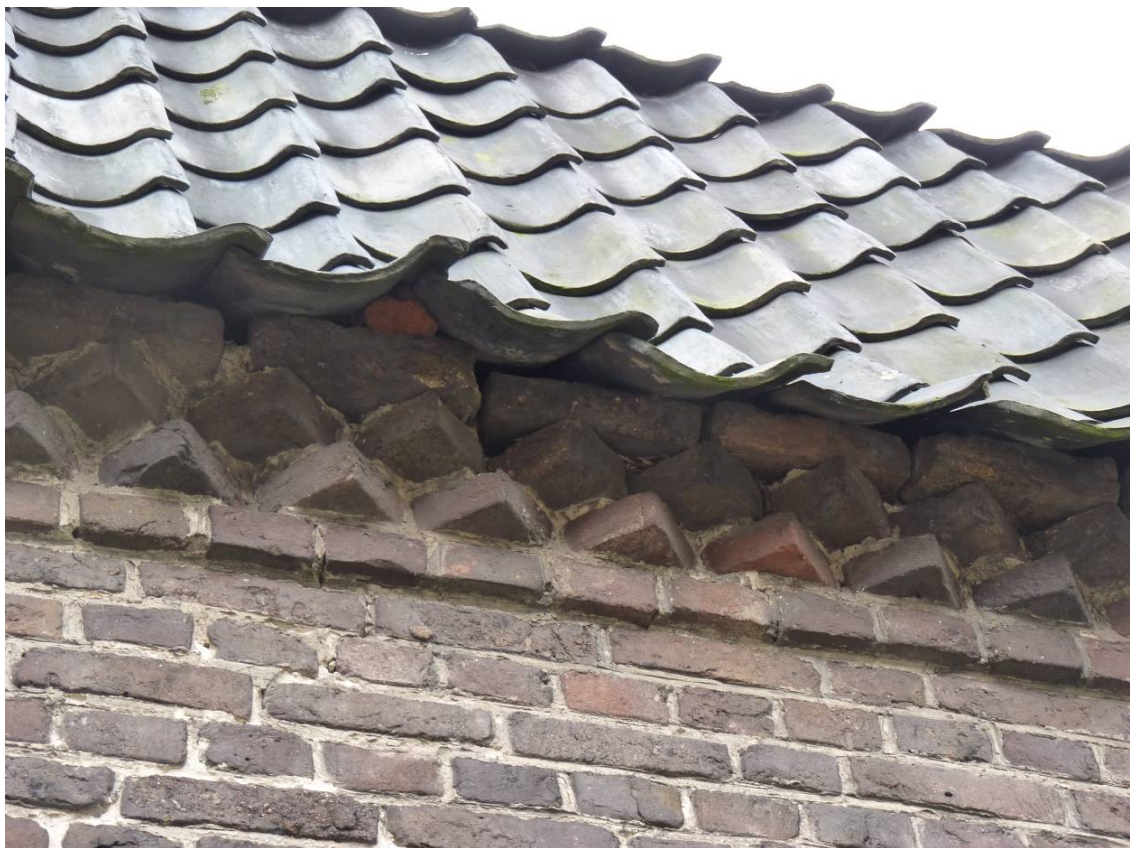
Figuur 4 De dakrand heeft een ornament van twee horizontaal verspringende muizentanden
