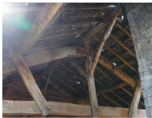
Figuur 32 Het bovenste driehoekspant
