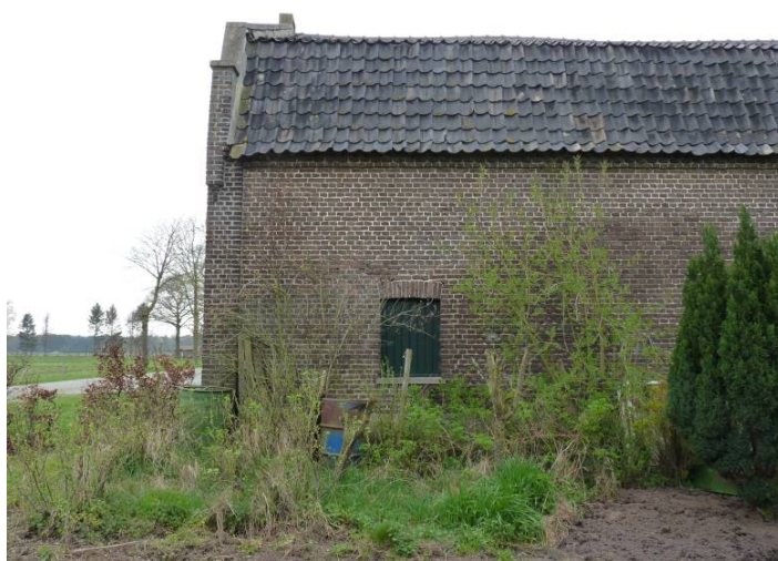
Figuur 38 Luik in achtergevel van voormalige schapenstal
