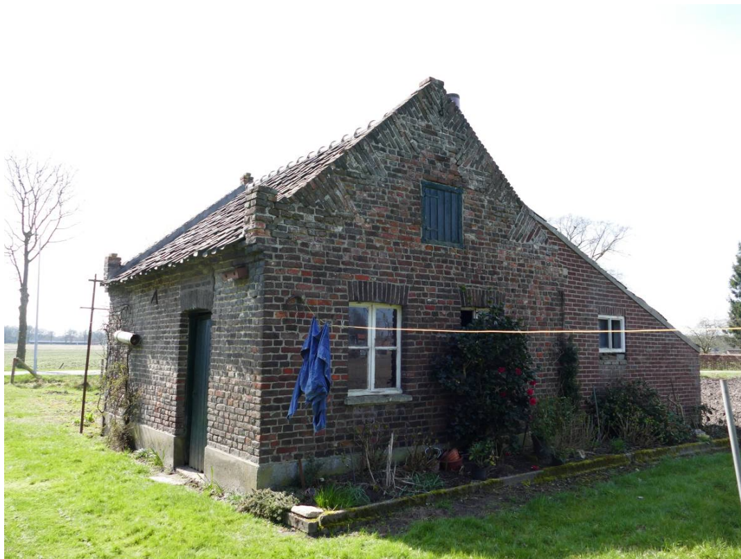
Figuur 52 Bakhuis met vlechtelingen in topgevel (noordzijde)
