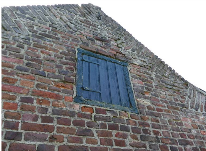
Figuur 56 Het luik in de noordgevel heeft een houtgepend kozijn en oud hangwerk
