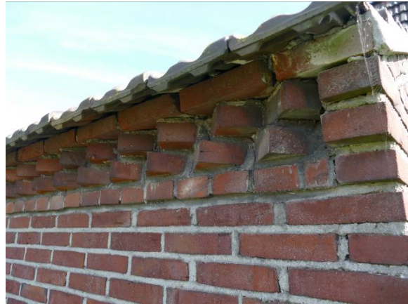
Figuur 18 Het ornament van de dakrand van het hoofdgebouw wordt voortgezet in de latere aanbouw
