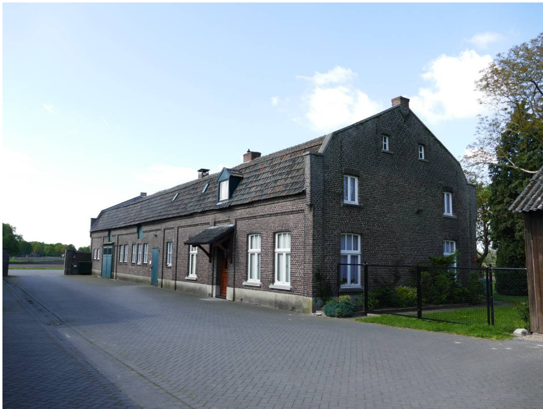
Figuur 10 De voorgevel (oostgevel) heeft een opbouw met lisenen en spaarvelden
