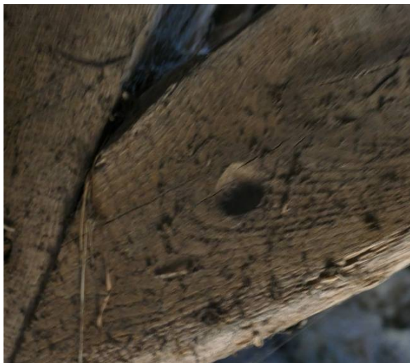
Figuur 34 Het telmerk 1 op de schoor van het juk in de vorm van met de guts aangebracht rondje
