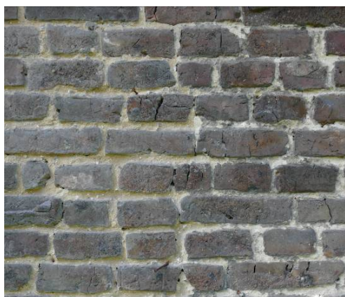
Figuur 53 Het muurwerk is van afvalstenen in wildverband
