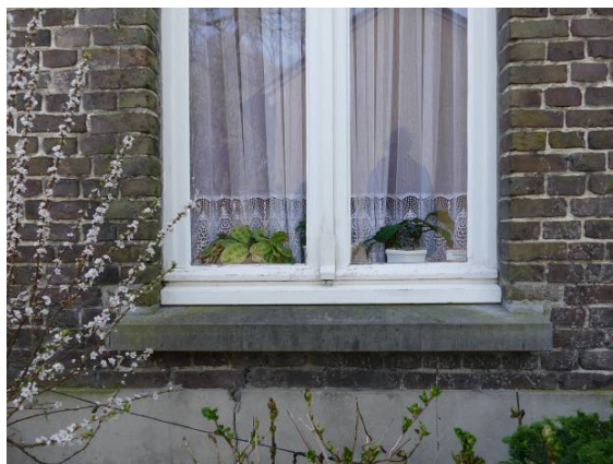
Figuur 3 De woonhuisvensters hebben een smal kozijn dat diep in de gevel ligt
