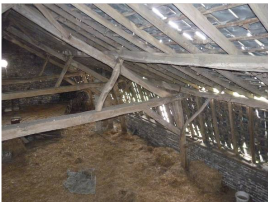
Figuur 50 De spanten steunen ter plaatse van de ijzeren balken met een slof op de betonnen vloer
