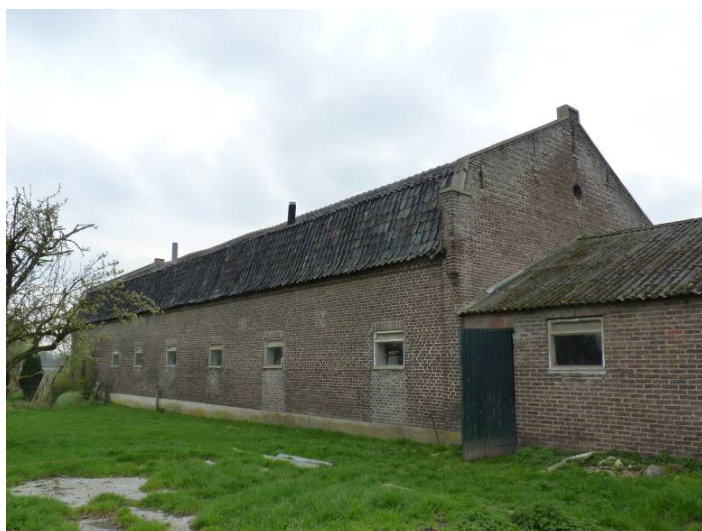
Figuur 37 Achterzijde van schuur met bouwsporen van deuren
