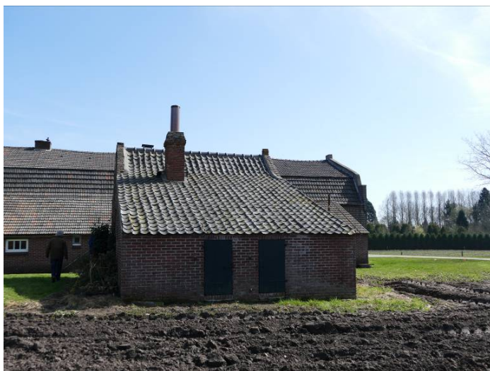
Figuur 55 Achterzijde (westzijde) met varkensdeurtjes en schoorsteen boven oorspronkelijke achtergevel van bakhuis
