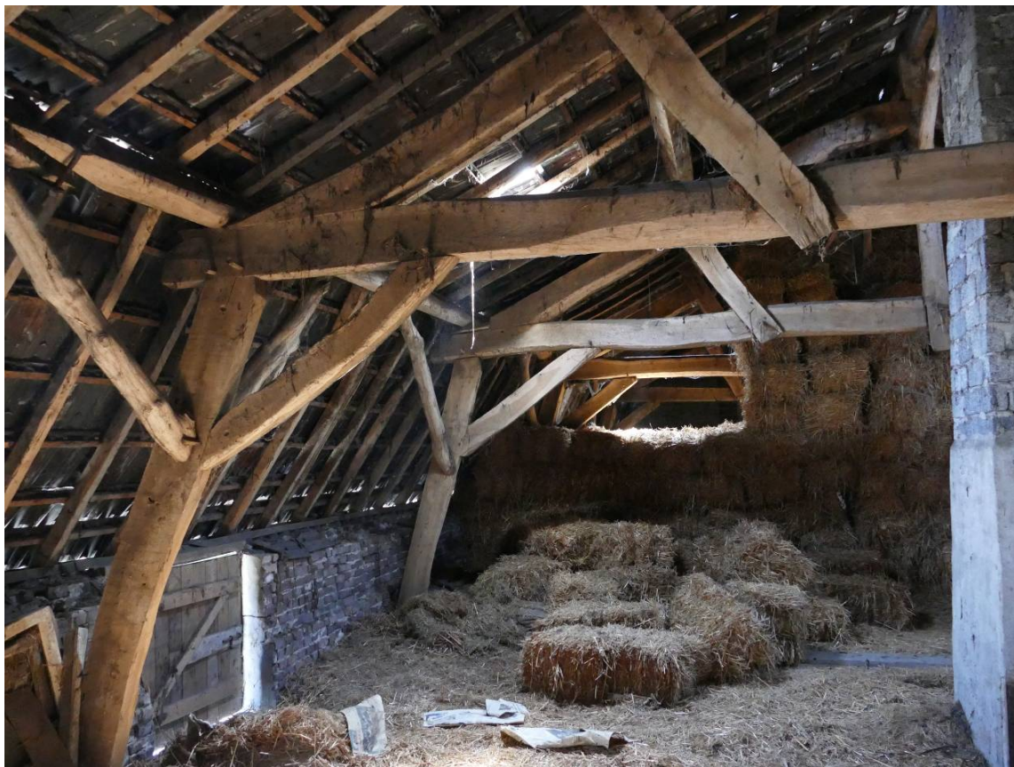
Figuur 30 De spanten van het stal- en schuurgedeelte
