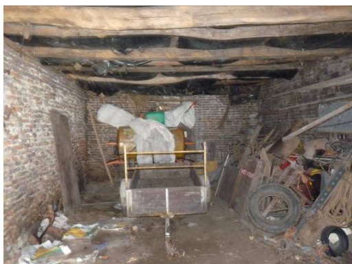
Figuur 45 De schapenstal heeft nog het originele plafond van robuuste slieten met matten van twijgen
