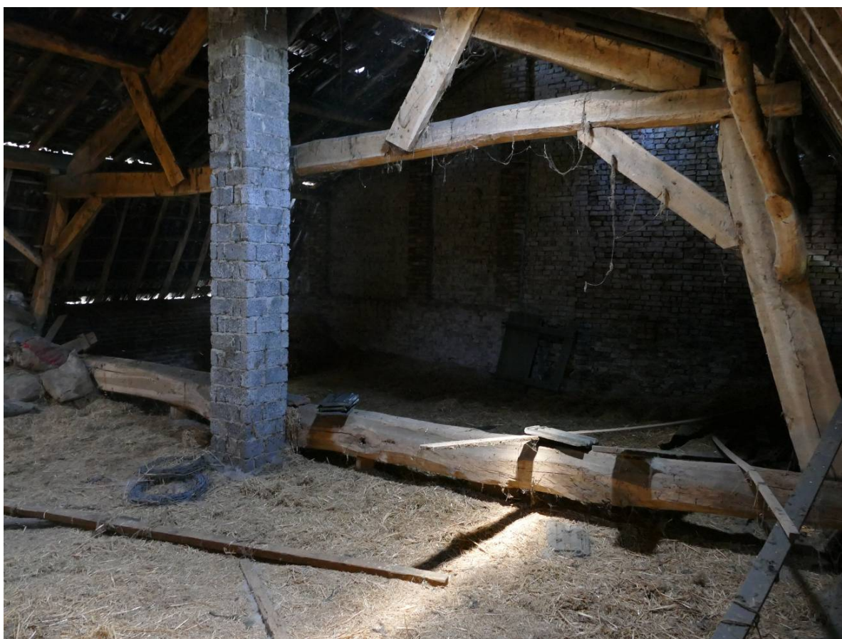
Figuur 35 Het kaspant in het schuurgedeelte steunt nog op de oorspronkelijke ligger
