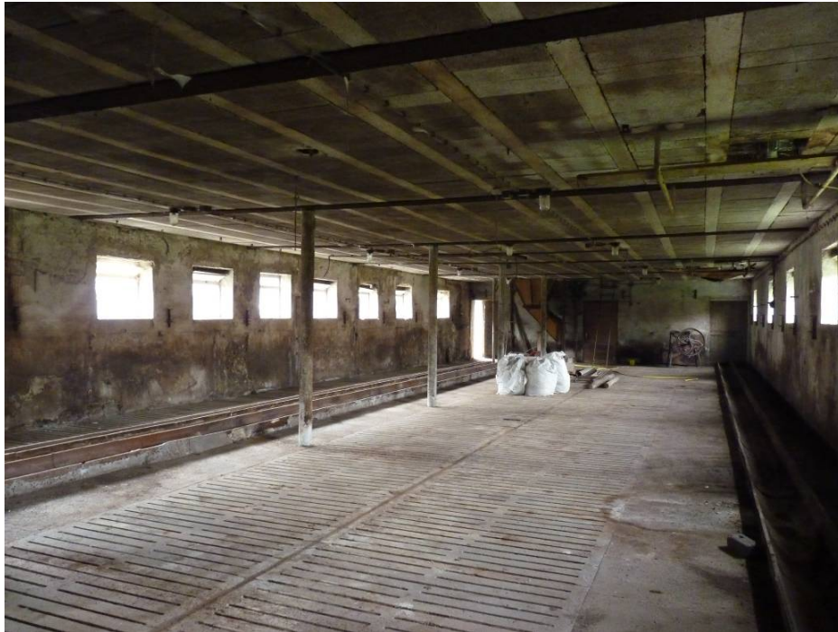
Figuur 42 Interieur van de stal voor fokzeugen. De ijzeren hekken tussen de varkenshokken zijn verwijderd
