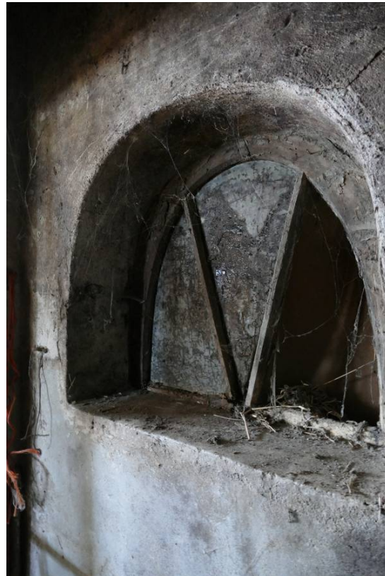
Figuur 28 Oorspronkelijk houten stalraam
