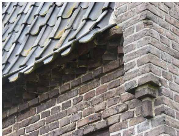
Figuur 40 Fraai metselwerk in handvormsteen aan daklijst en hoekliseen
