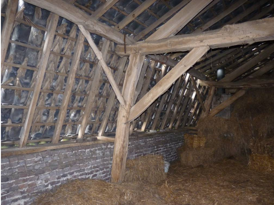
Figuur 47 De jukken van de kapconstructie met fliering
