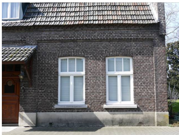
Figuur 11 In het eerste spaarveld van de voorgevel liggen de ramen van de “mooie” kamer. Aan de bovenzijde de overgang van spaarveld naar dakrand
