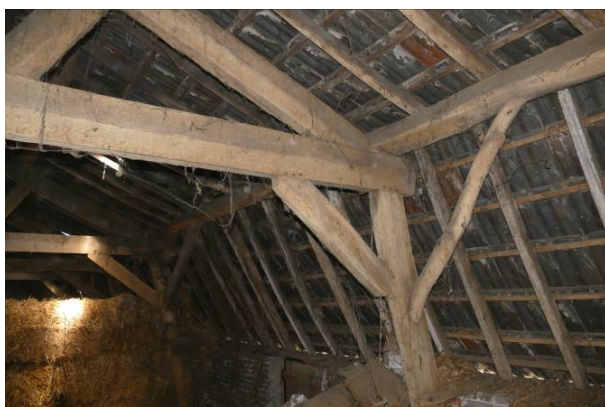
Figuur 31 De kapsanten bestaan uit een juk en daar op een driehoekspant. Ze zijn op ambachtelijke wijze samengesteld
