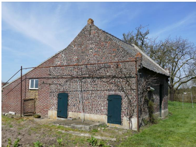
Figuur 54 Topgevel zuidzijde met vlechtingen, traptuit en hoekornament. De varkensdeurtjes zijn van later. Gevel is opgetrokken uit afvalsteen in wildverband.
