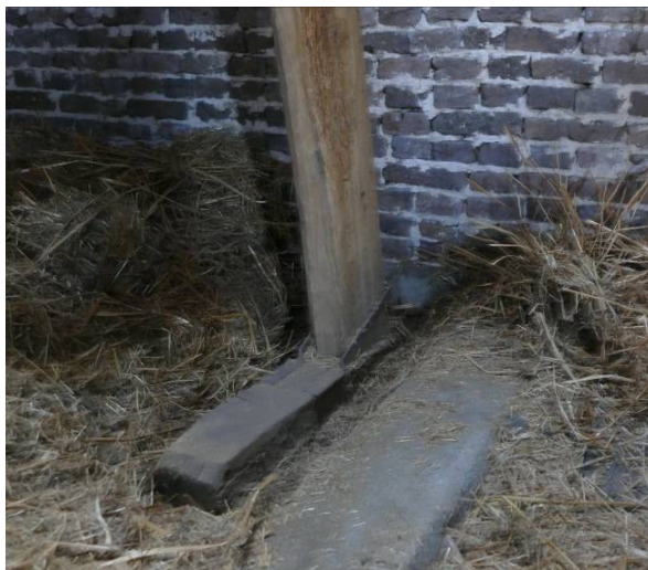
Figuur 33 Spantbeen steunt op een slof op de betonnen vloer (cusvellervloer)
