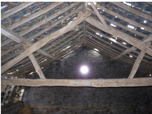
Figuur 48 Het driehoekspant heeft in de schuur geen makelaar
