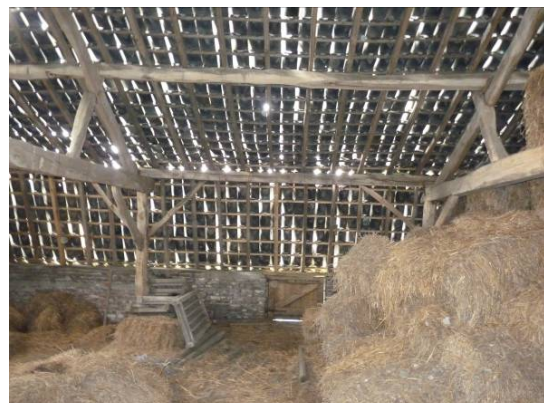
Figuur 51 Travee van kap met onderaan hooiluik van voorgevel schuur
