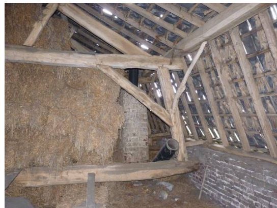
Figuur 49 In de schuur bevindt zich nog een eiken ligger waarop het kaspant rust
