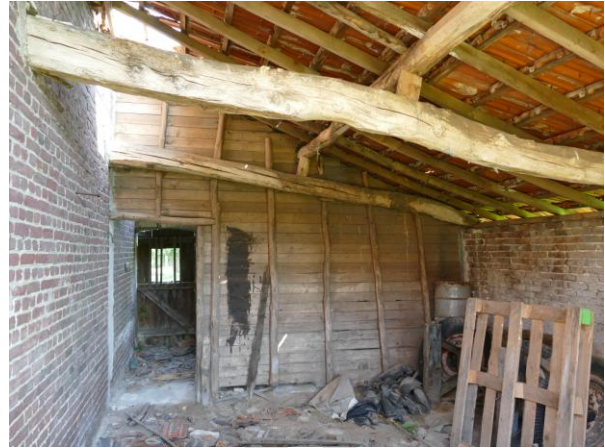
Figuur 33. houten scheidingswand in de afhang
