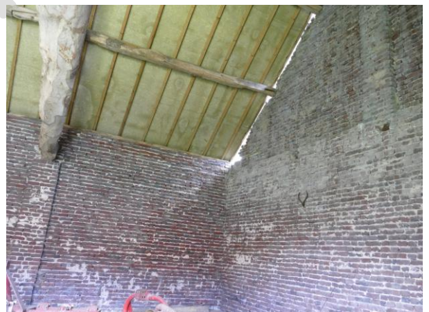
Figuur 31. interieur van de schuur met zware eiken ligger rustend op een penant in de muur
