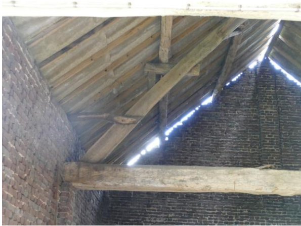
Figuur 32. kapconstructie met links van onder naar boven: eiken ligger op penant, blokkeel op muurplaat, driehoekconstructie onder fliering. Rechts in de topgevel de penant van de nokbalk.
