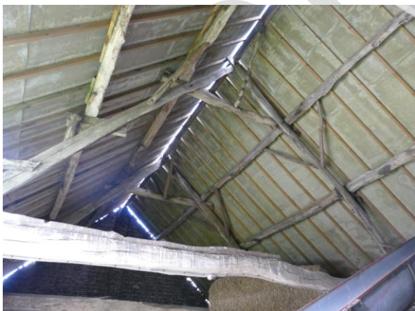
Figuur 30. kapconstructie schuur: de kasporen zijn nieuw en afgedekt met internietplaten
