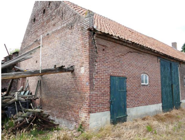
Figuur 10. schuurgedeelte: muur van tasruimte is in halfsteens verband vernieuwd. Zuidgevel met vlechtingen en hoekornament.
