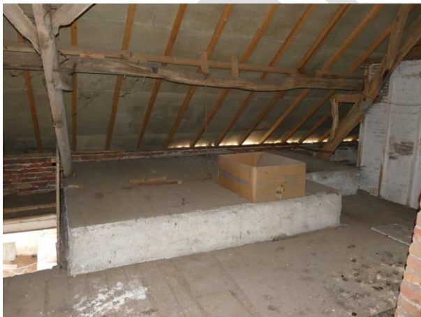
Figuur 20. Plafond van opkamer steekt boven de zoldervloer uit. Rechts de wand van de knechtenkamer.
