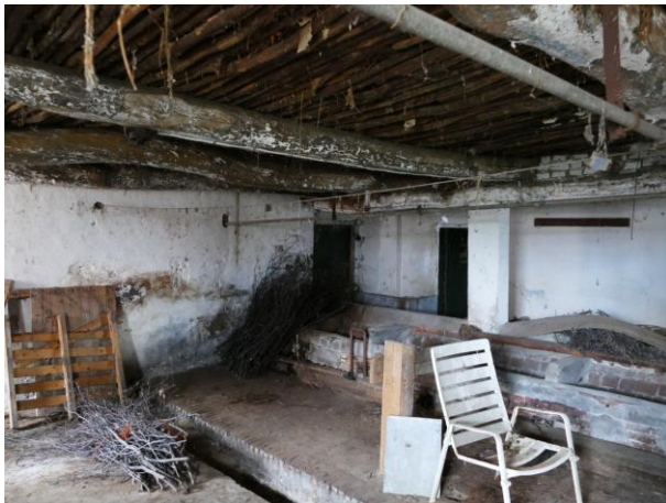
Figuur 22. stal met gemetselde voerbakken en grup. Zoldering met slieten en twijgen
