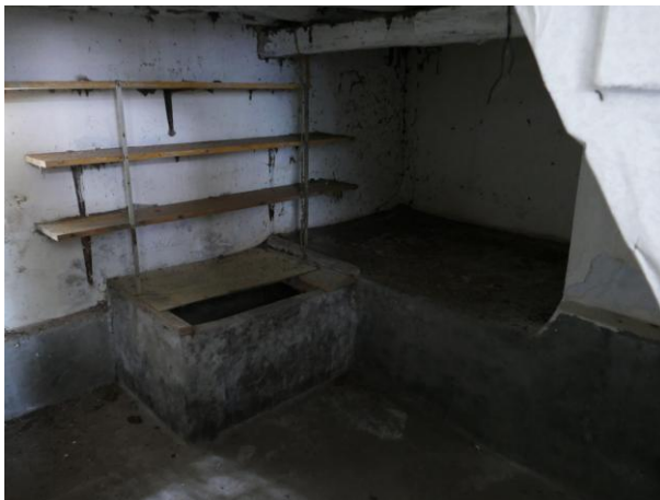
Figuur 18. interieur kelder
