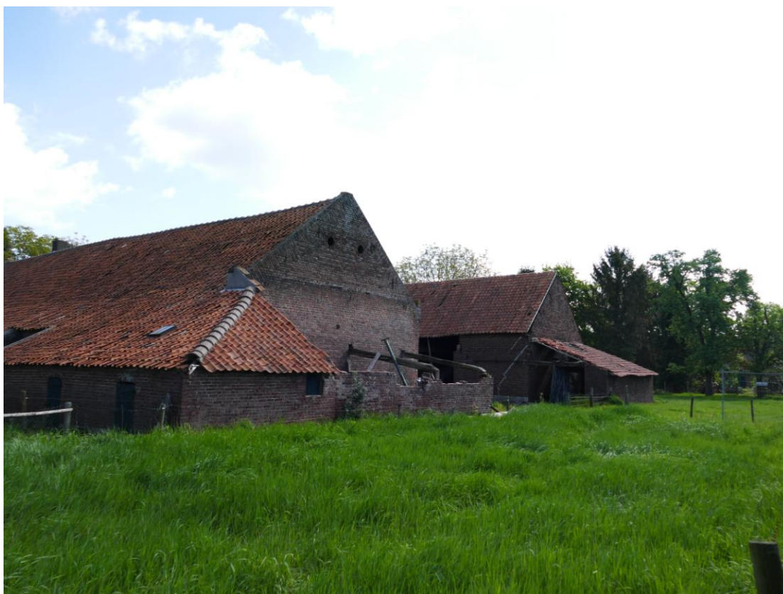
Figuur 5. boerderij en schuur gezien vanuit het zuidwesten
