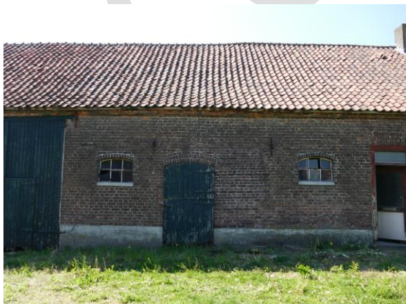
Figuur 8. stalgedeelte met vaag bouwspoor van voormalige dubbele mestdeur
