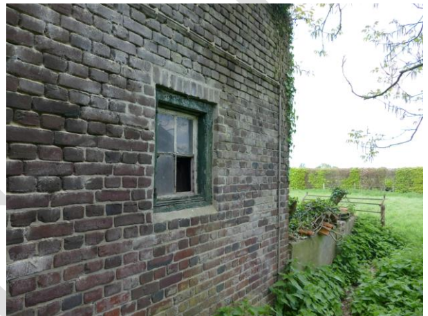
Figuur 29. dit raampje is later aangebracht
