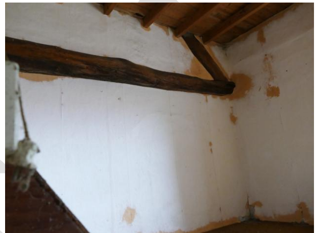
Figuur 19. De moerbalk van de herd loopt door in de wand van de opkamer. Hier is hij ontdaan van al het stucwerk. De schuine balk rechts is het spantbeen van het kapsant
