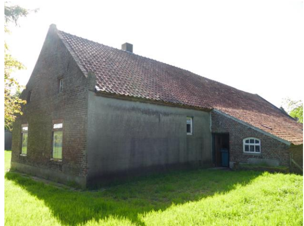
Figuur 11. noordwestzijde met keuken in uitbouw
