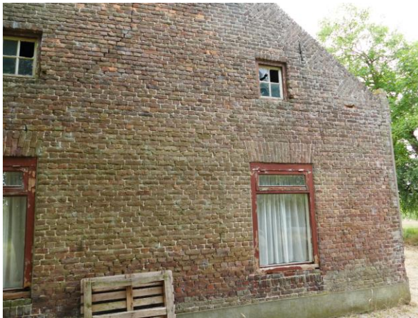
Figuur 12. noordgevel: opgetrokken in handvormsteen met vlechtingen
