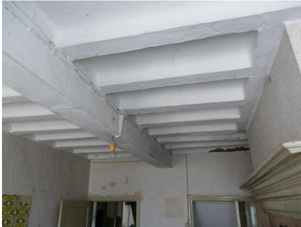
Figuur 16. balkenplafond van de herd.
