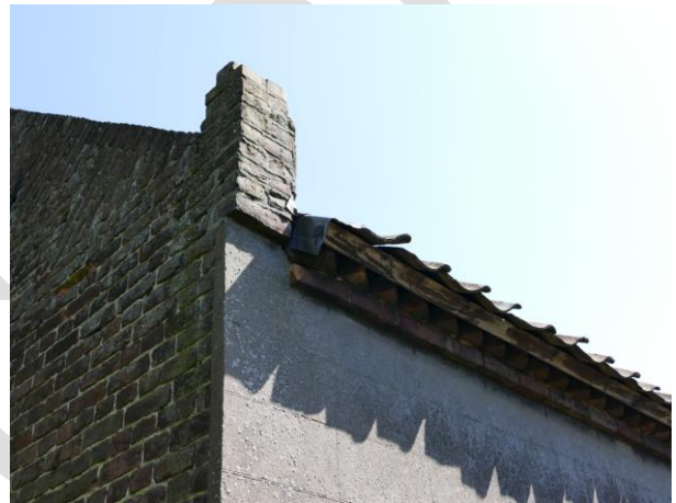
Figuur 13. hoekaansluiting noordwestzijde met muizentand en gecementeerde westgevel
