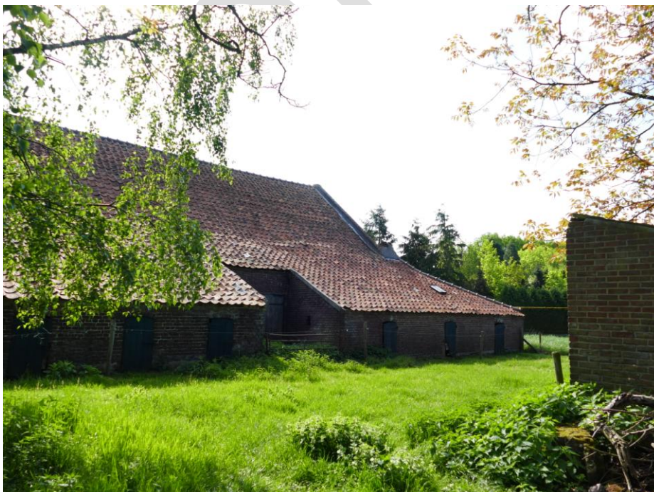
Figuur 14. westgevel: uitbouw met varkenshokken
