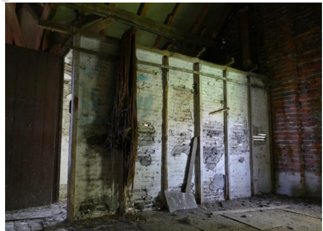
Figuur 21. Een van de twee knechtenkamers aan de kopgevel
