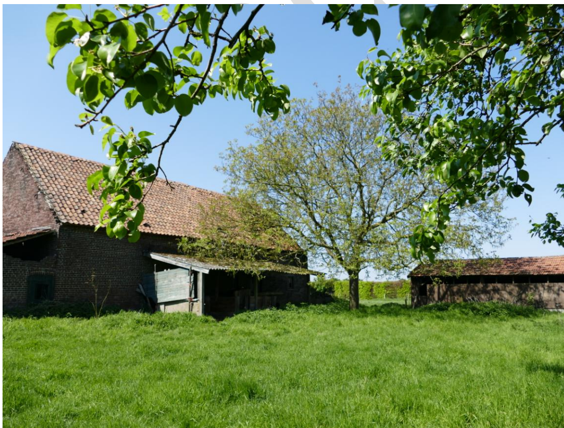
Figuur 6. achterzijde van de schuur gezien vanuit het zuidoosten met rechts het kippenhok
