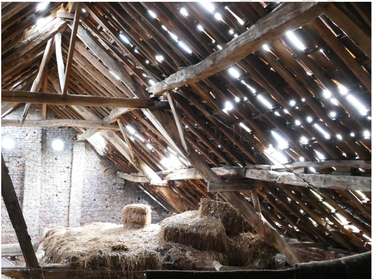
Figuur 24. Kap met A-spanten. Onder de driehoekconstructie.
