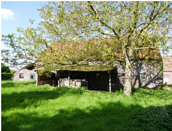
Figuur 26. achterzijde schuur (oostzijde)
