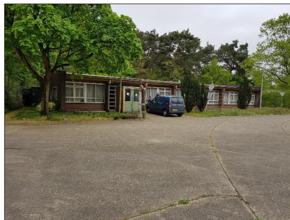
Figuur 10. Beheergebouw bij ingang in het zuiden
