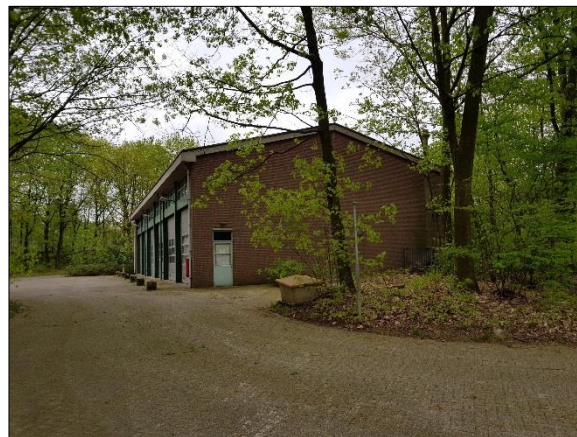
Figuur 8. Centrale loods in plangebied met open stootvoegen
