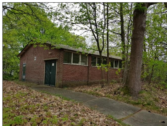
Figuur 4. Gebouw in plangebied
