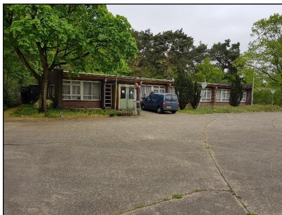
Figuur 10. Beheergebouw bij ingang in het zuiden
