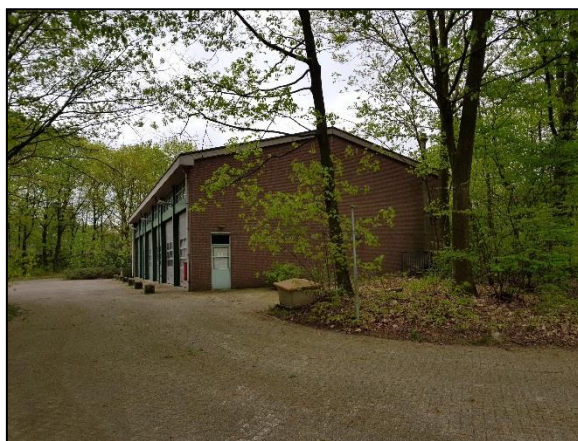
Figuur 8. Centrale loods in plangebied met open stootvoegen
