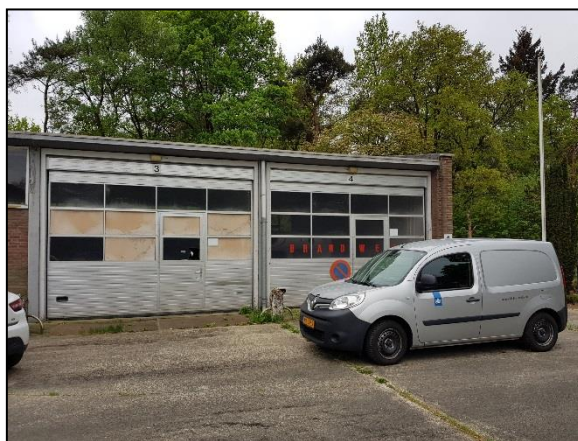
Figuur 6. Loods in w esten plangebied
