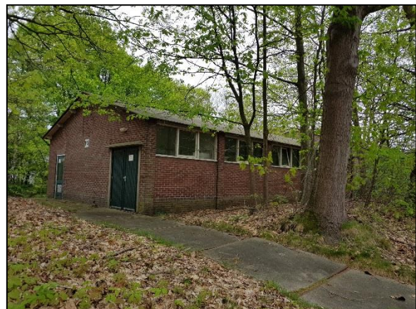
Figuur 4. Gebouw in plangebied
