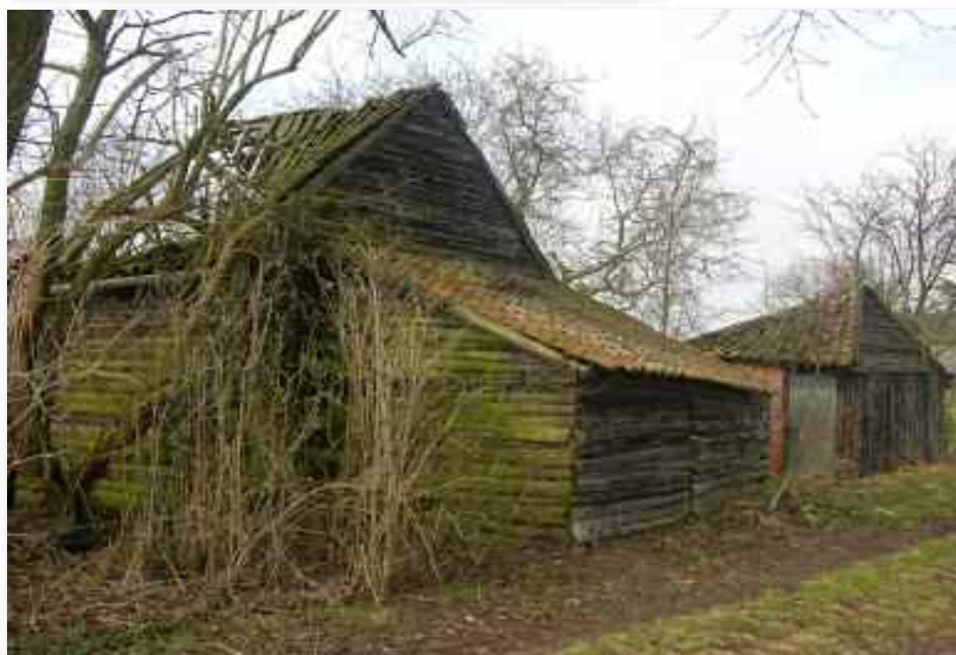
10. De overgang naar de zuidgevel
