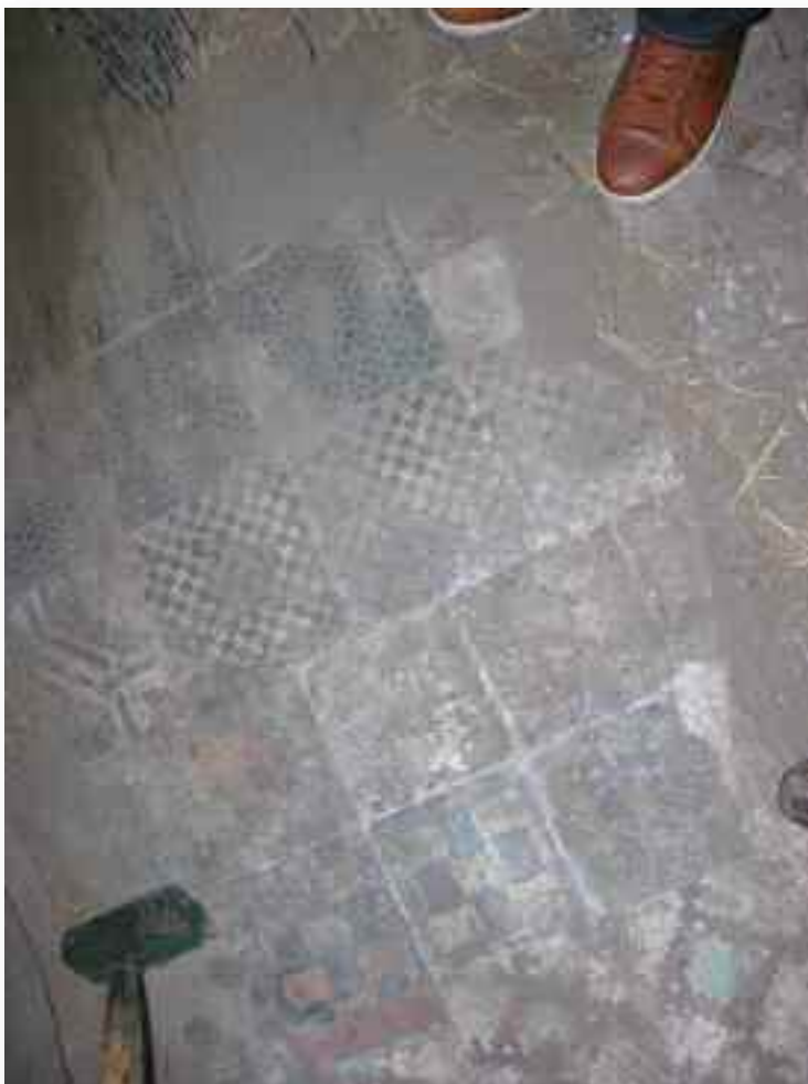
28. De uit restanten samengestelde vloer
