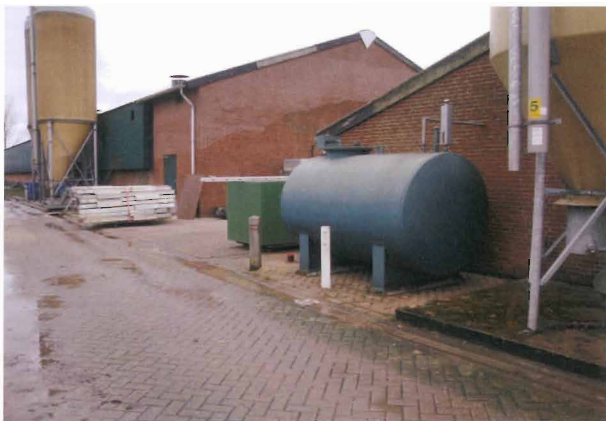
foto 1: bovengrondse dubbelwandige dieselolietank (circa 5.000) op klinkerverharding, aangrenzend ten noordwesten van de meest noordelijk gelegen varkensstal.
