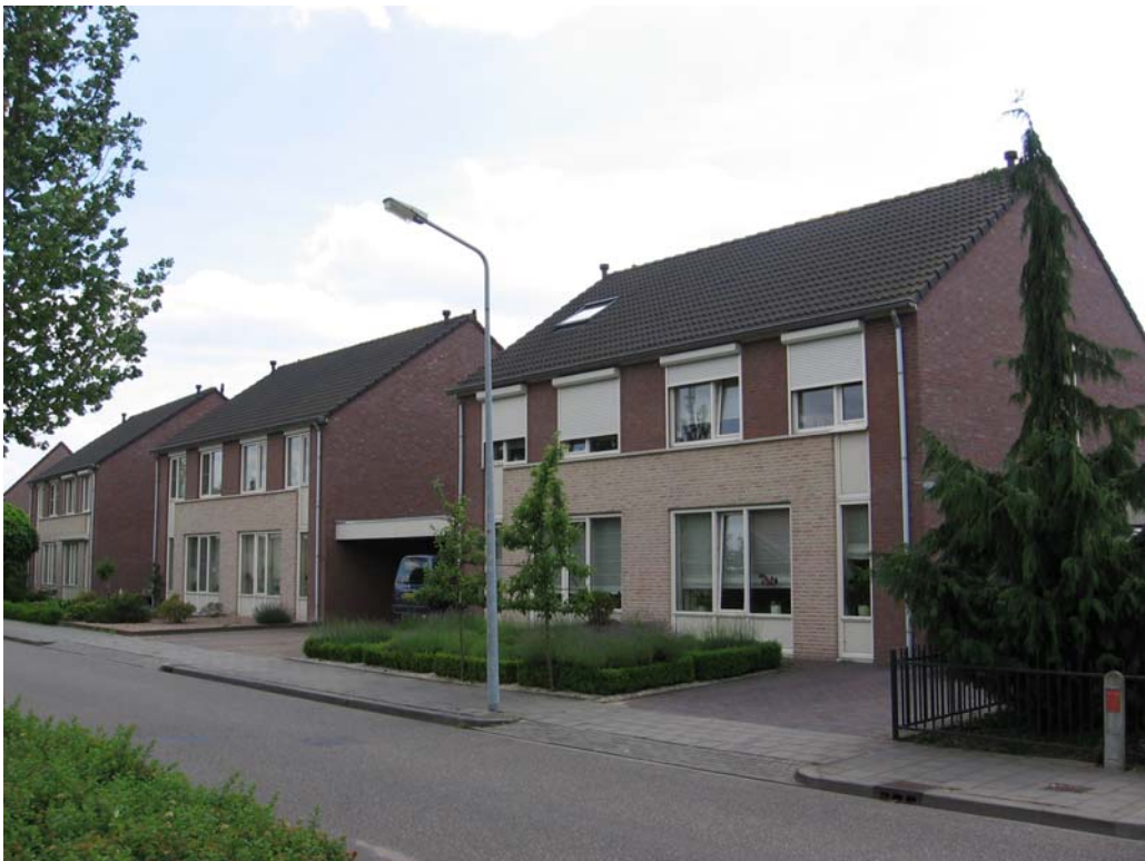
Foto 4. bebouwing ten westen van de locatie met meer geschikte openingen en potentiële verblijfplaatsen voor vleermuizen
