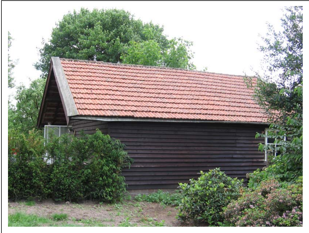
Foto 5. één van de te slopen schuren, opslag van materialen
