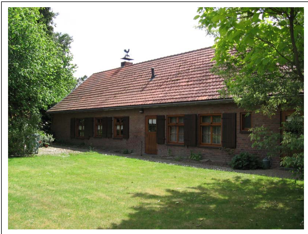
Foto 2. achterzijde van het te slopen woonhuis
