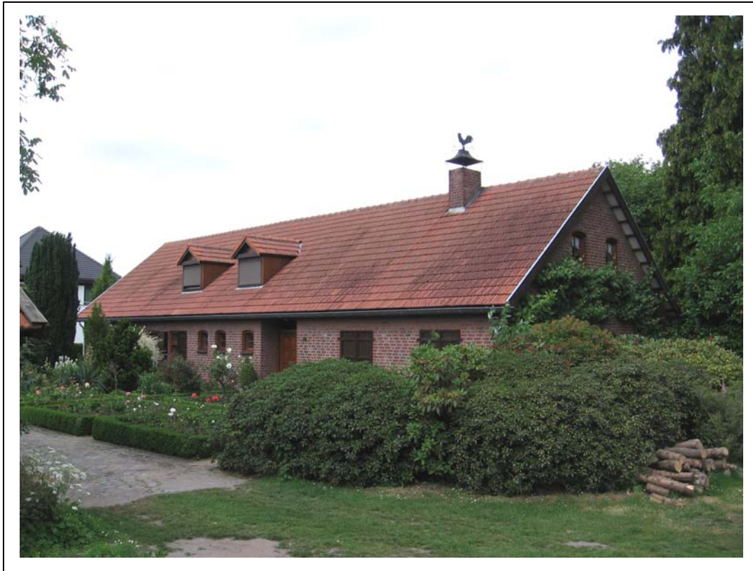
Foto 2. voorzijde van het te slopen woonhuis
