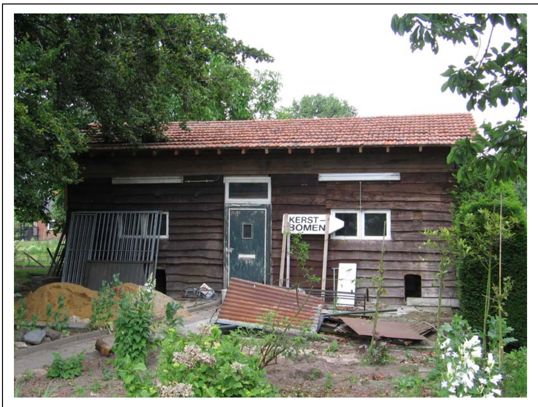
Foto 6. één van de te slopen schuren, tevens in gebruik als kippenhok
