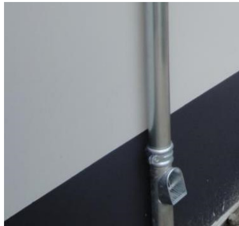
Zinken hemelwaterafvoeren met bladvangers
