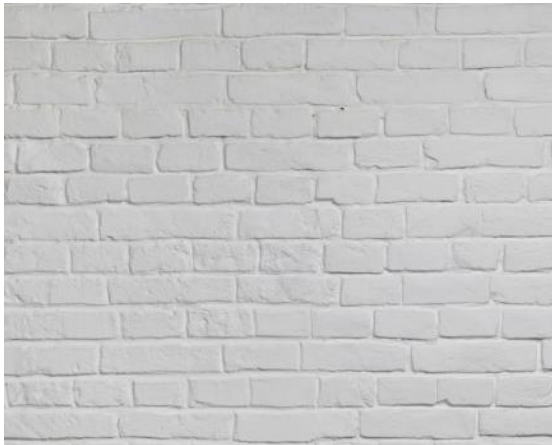
Keimwerk in metselwerk platvol gevoegd
