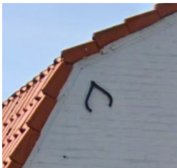
sierbeugels & gecementeerde gevelpan en/of rollaag
