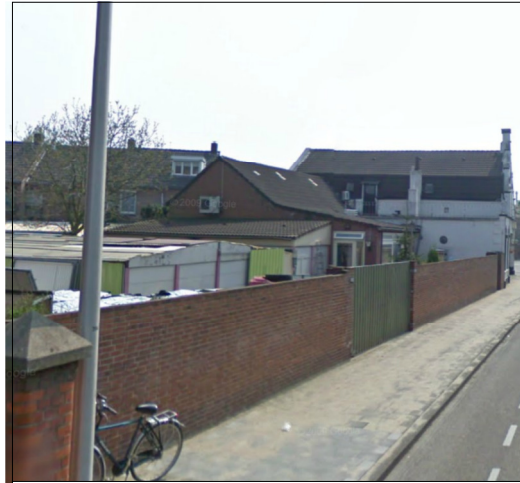
Bouwwerken op het achterterrein
