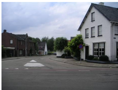
Beekpoort met aanzet richting Hushoverweg
